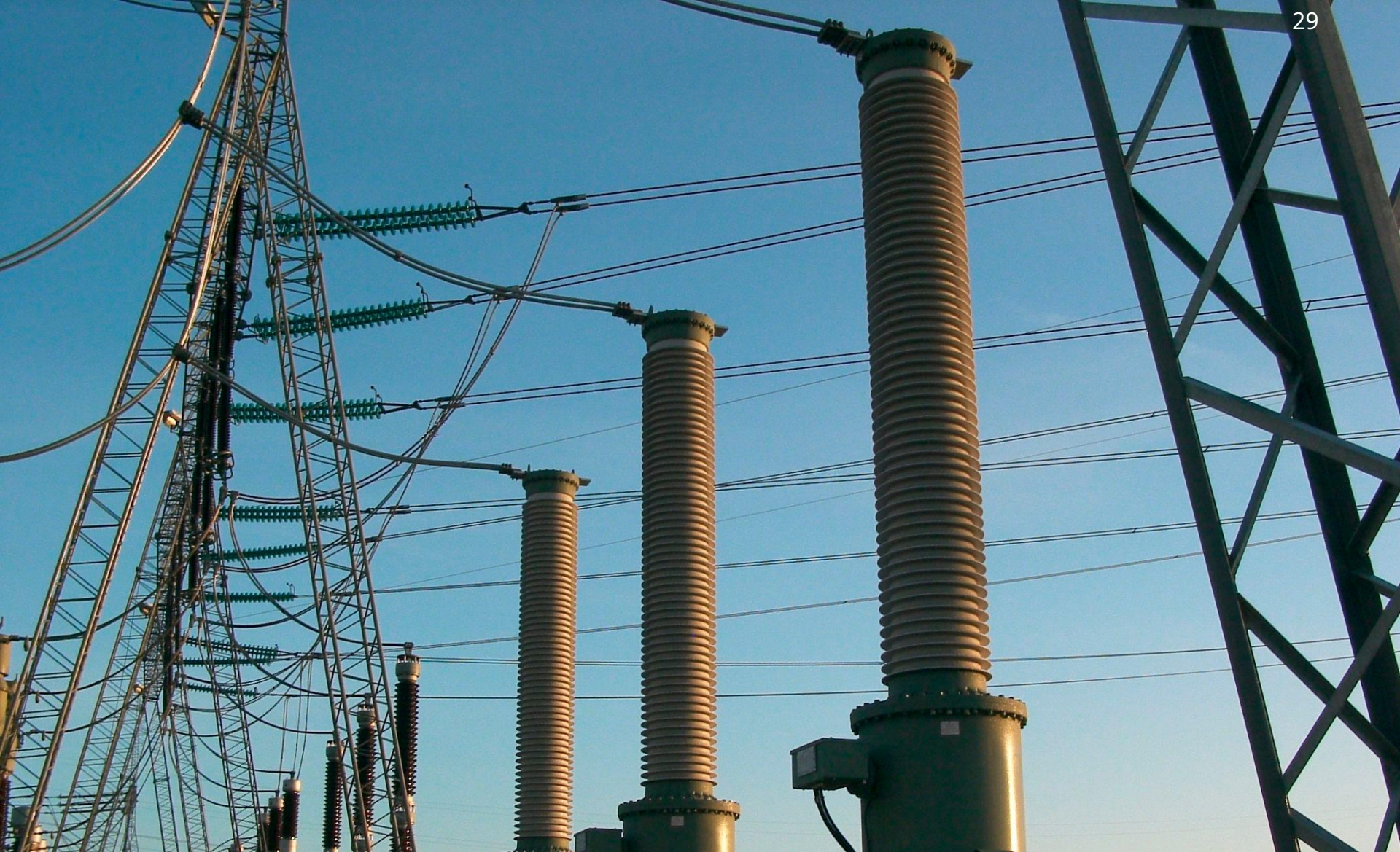
Transformadores de Medida de Tensión (VT)
